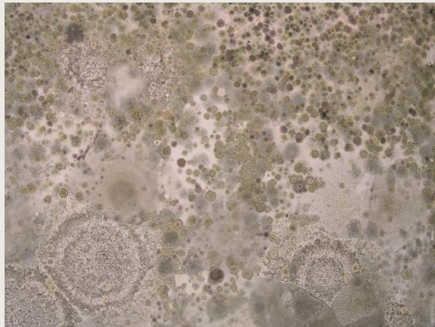
Muggsoppvekst på gipsplate.
