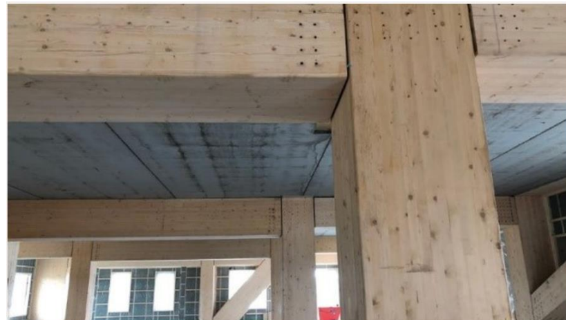
Bæresystem av limtre, her med betongdekker
