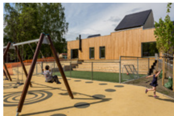
Kistefosdammen barnehage i Asker er det første offisielle plusshuset i Norge. Bygningen har utstrakt bruk av tre med blant annet massivtre i takkonstruksjonene. Christensen og Co Arkitekter AS. Foto: Tove Lauluten
